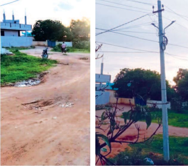
అధ్యాపంగా బసి కాలనీ రోడ్డు
